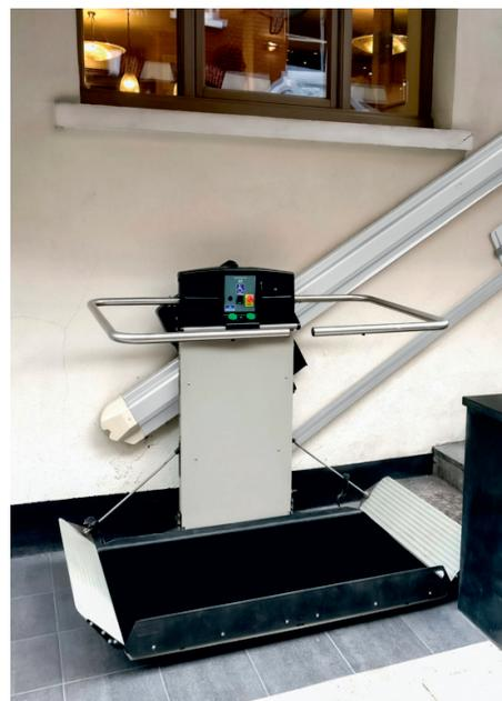
萨瓦瑞亚旗下Garaventa X3 斜挂式升降平台是一种简单经济的解决方案，适用于商业建筑内的直线型楼梯。X3斜挂式升降平台通常可在一天内完成安装，无需对现场进行改造。折叠后占用空间小，不影响楼梯使用。萨瓦瑞亚 X3 斜挂式升降平台，助力场所实现无障碍通行。
